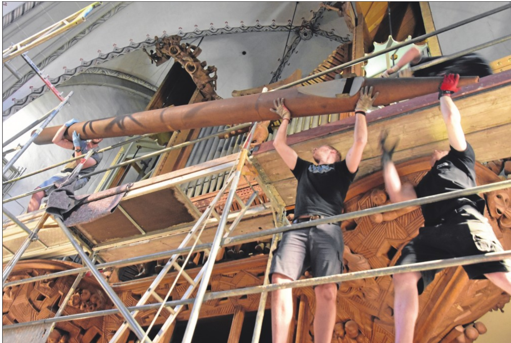
Mitarbeiter der Firma Klais heben das 5,5 Meter lange tiefe Cis der Prinzipale 16 aus seiner Verankerung.
